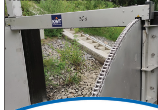
36a. jelű műtárgy a Kápolnai-Gürü-csatorna 3+140 km szelvényében
