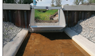
U-4 jelű műtárgy a Sellyei-Gürü-csatorna 9+075 km szelvényében
