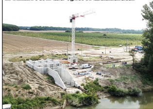
A vízivételi mű építési munkáit
