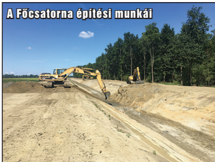
A Főcsatorna építési munkái
